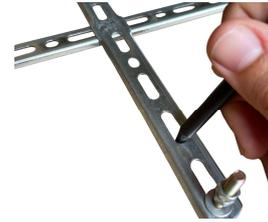
**3.** Sem retirar os parafusos que apertam a base do candeeiro ao suporte, utilize o suporte de fixação traseiro para efetuar as marcações dos pontos onde vai realizar as furações no teto.
