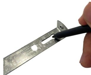
2. Retire o suporte de fixação e faça as marcações das furações na parede.
